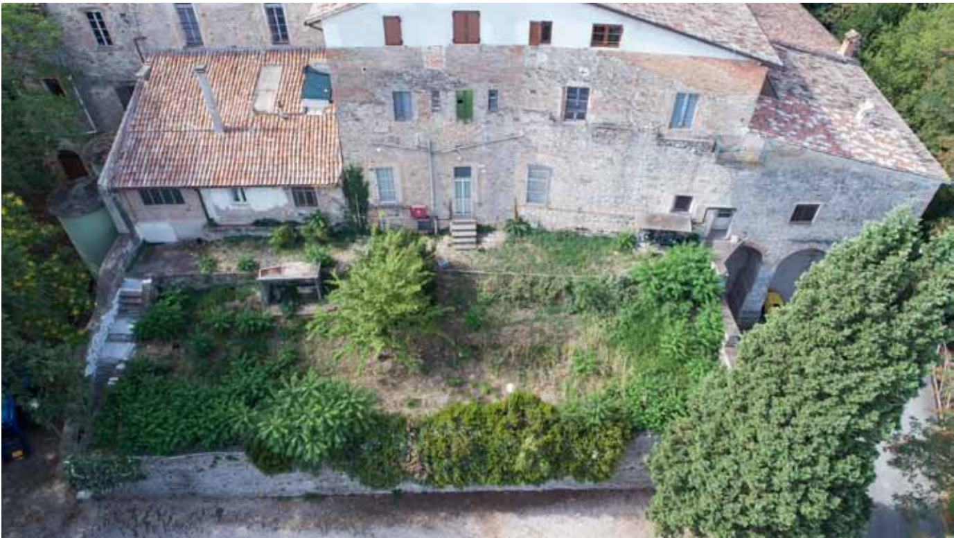
Situazione dell'area prima dell'intervento.
