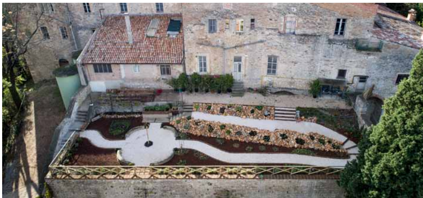
Situazione dell'area dopo l'intervento.
