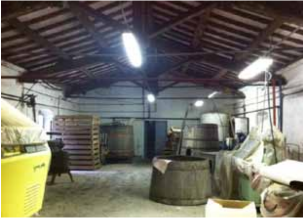
Alcune immagini dello stato della cantina prima dei lavori
