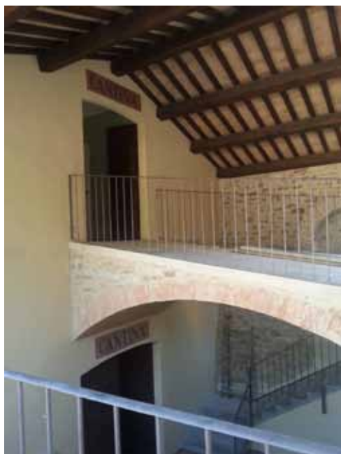
La cantina al termine dell'intervento di recupero
