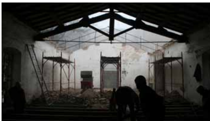
Alcune immagini dell'esecuzione dei lavori
