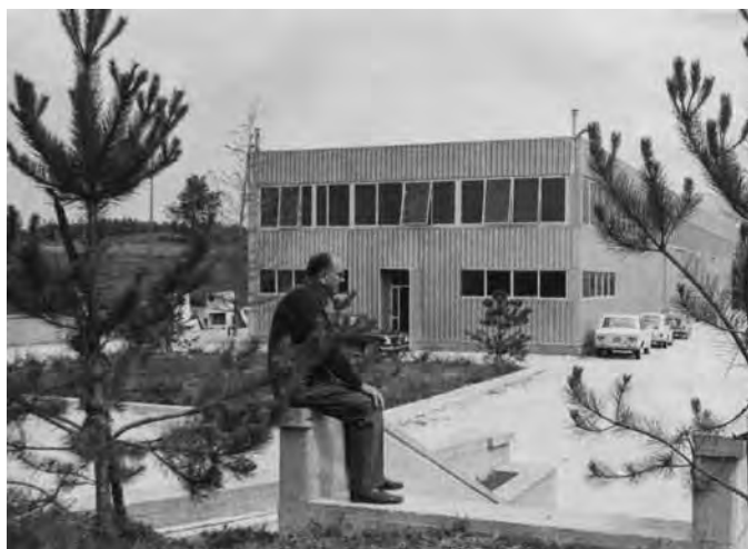
Costruzione dello stabilimento ACS a Cimacolle, 1972
