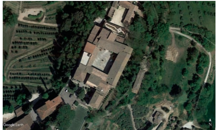
Fig. 1: Vista aerea dell'area indagata
