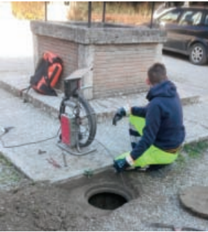
Fig. 3 - Cisterna del chiostro: indagini con videocamera
