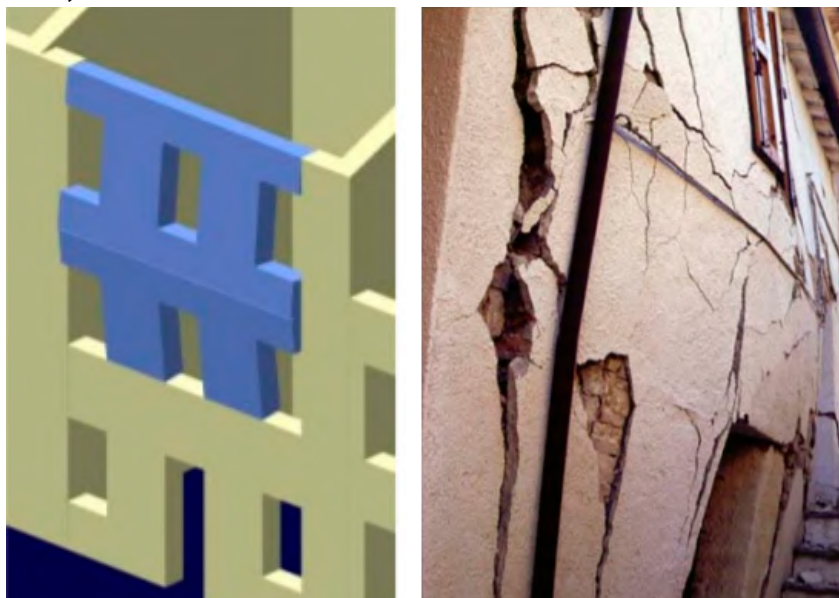
Fig. 33 - immagini che illustrano il meccanismo di flessione verticale, riportate nelle schede illustrative dei principali meccanismi di collasso allegate alle Linee Guida per la Riparazione e il Rafforzamento di elementi strutturali, Tamponature e Ripartizioni (ReLuis e Protezione Civile, 2011)
