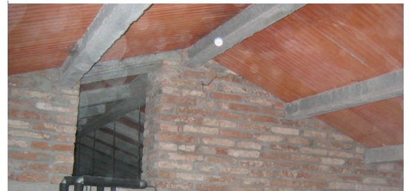
Fig. 9 - riprese fotografiche del sottotetto dell'edificio
